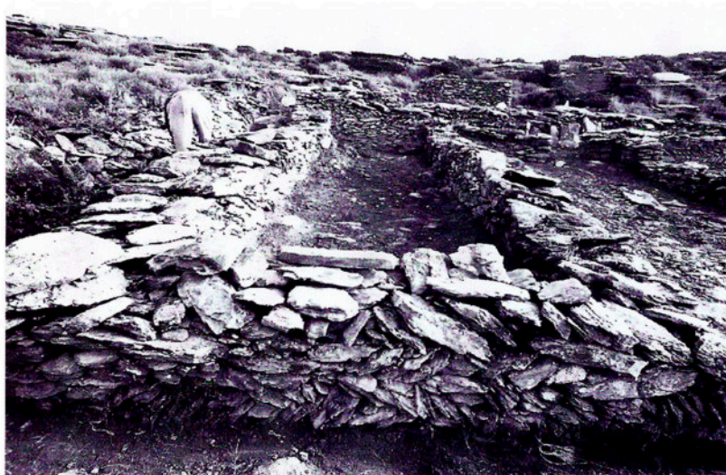
Treballs d'excavació a l'esglésiola de Sant Tomàs de Pení, any 1972.
