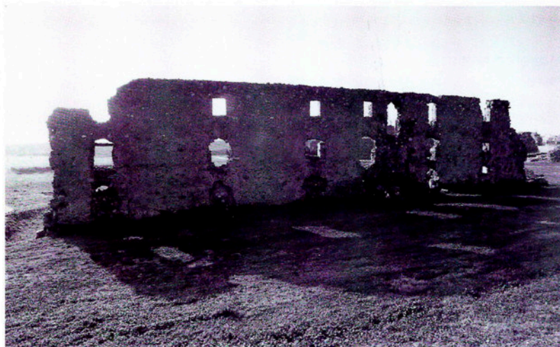
Façana en ruïnes que encara es conserva del bloc d'allotjament situat més al nord. És el costat on no hi havia la galeria. Es veuen els forats de les finestres.
