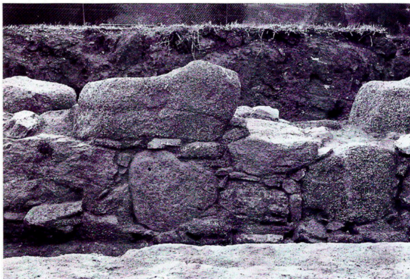
La muralla hel·lenística està construïda a base de grans blocs de pedra granítica local, de formes irregulars, units amb argila i pedres més petites.
